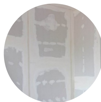
Beispiel: Leichtbauwand, verspachtelt
