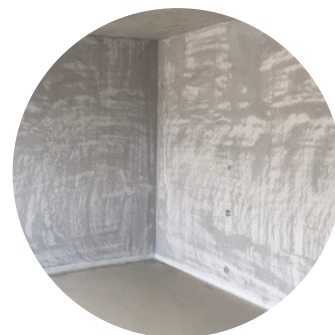
Beispiel: Backsteinwand mit Grundputz
