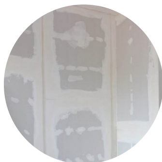
Beispiel: Leichtbauwand, verspachtelt
